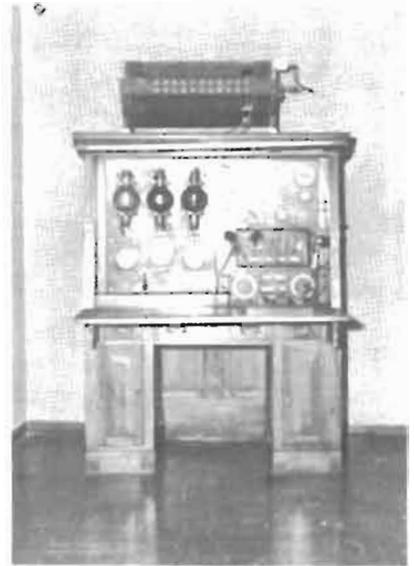
Fig. 8 - Un trasmettitore per Onde medie già impiantato sul panfilo «Elettra» Marconi donò l'apparato al D'Annunzio nel 1925 per dotare «Il Vittoriale» sul Garda.
